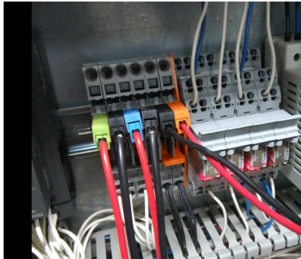
Abb. 5: Direkter Spannungsabgriff an der EZE
